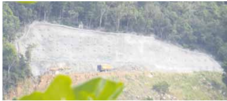
▲ Les travaux de confortement sur les hauteurs de Concordia sont à présent terminés : la construction des deux réservoirs du Mt des Accords devrait enfin pouvoir démarrer.
